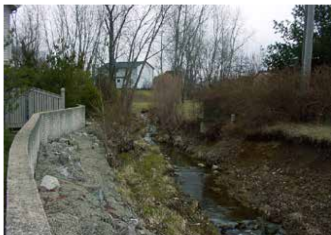
Figure 9.2 Érosion dans un cours d'eau dans un milieu bâti, rendant difficiles les interventions.
