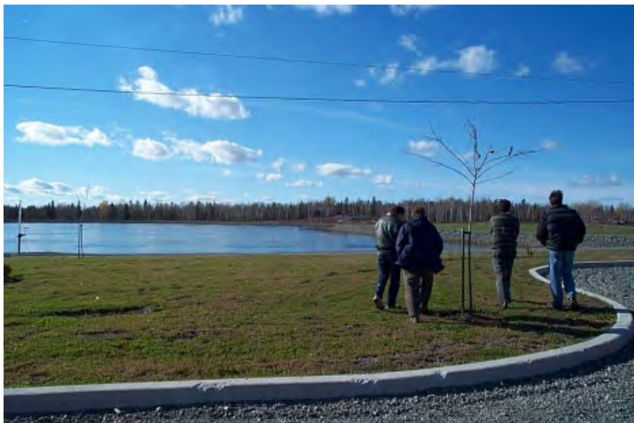
Figure 6 : Étangs aérés de traitement des eaux usées de la Ville
