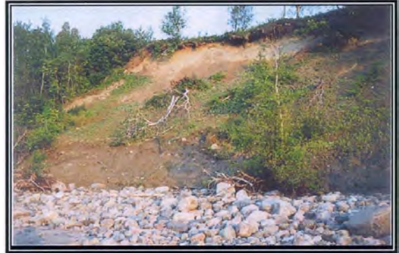
PHOTO 3 : On distingue au sommet de la pente, une section en porte-à-faux. Au centre du cliché, on observe un groupe d'arbre qui ont dégringolé à partir du sommet du talus.
