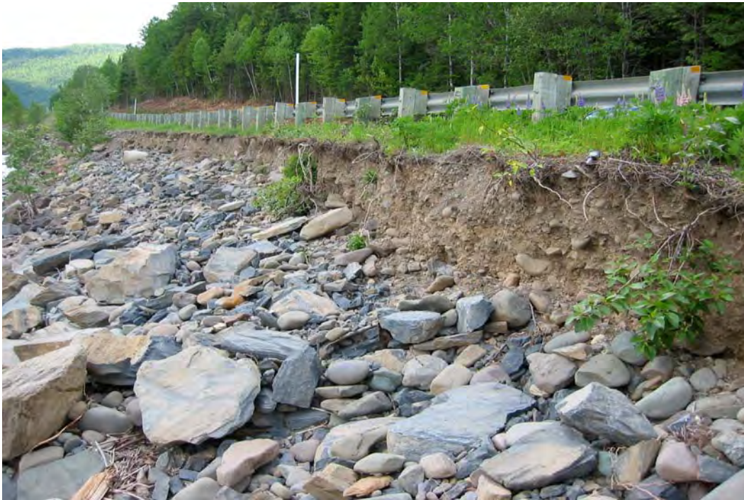
Figure 3 : Érosion de la rive près de la glissière de sécurité (site 7)
