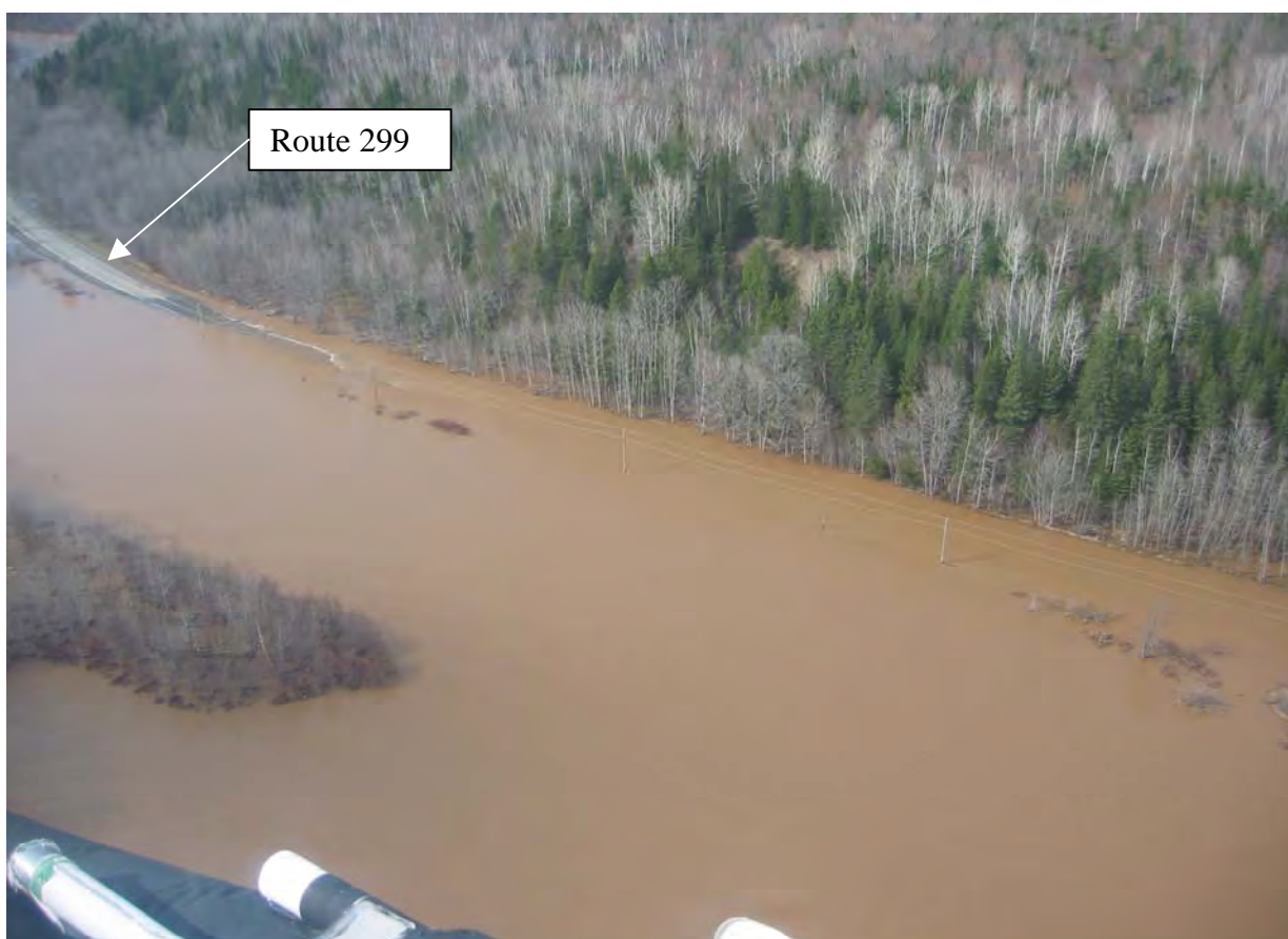
Figure 1 : Débordement de la rivière Cascapédia sur la route 299 lors des pluies diluviennes des 4 et 5 mai 2004
