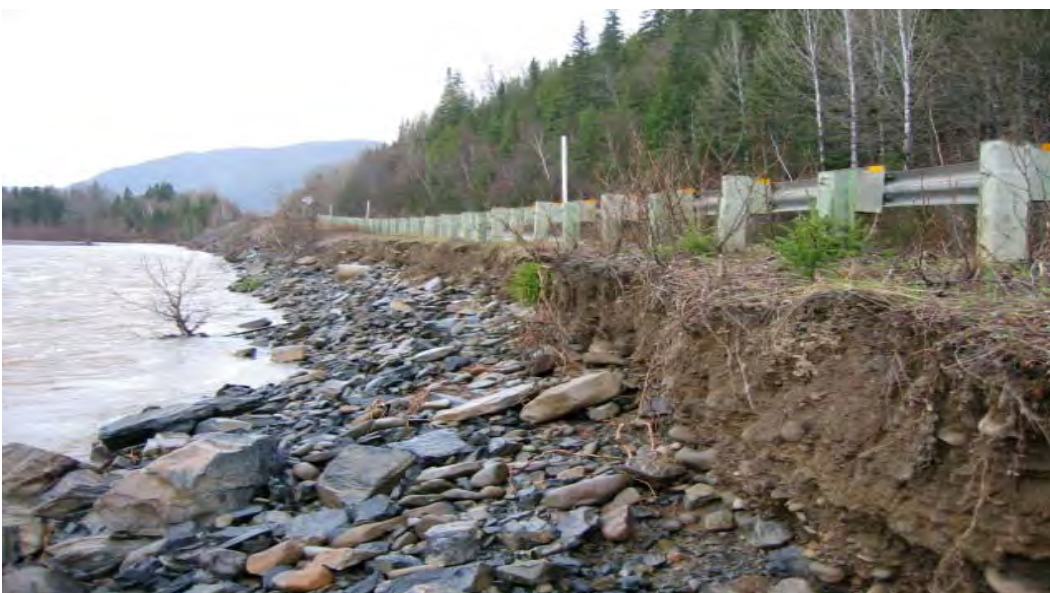
Figure 3 : Érosion de la rive près de la glissière de sécurité (site 7)
