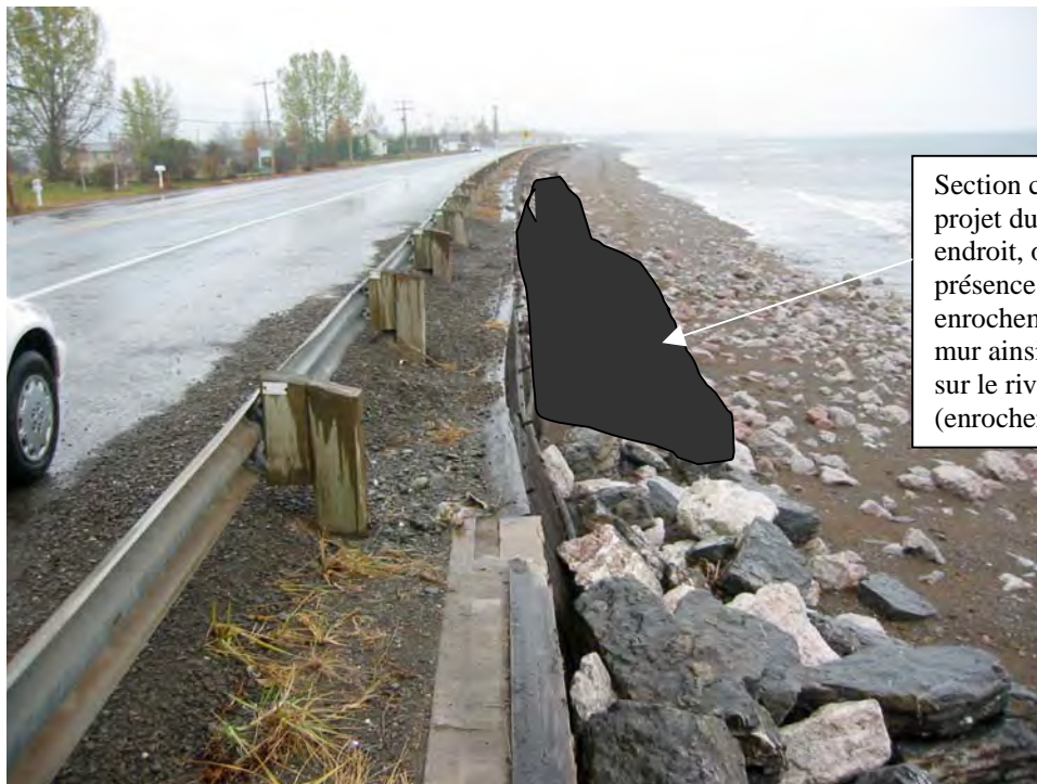
Photo 2 : Partie de mur détériorée à Maria (direction est), secteur immédiatement à l'est du ruisseau Martien (29 octobre 2003)
