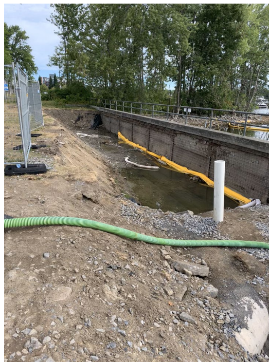
FIGURE 4 RETRAIT D'ENROCHEMENT LE LONG DU MURET AFIN D'ARRÊTER LA RÉSURGENCE À LA RIVIÈRE RICHELIEU (CFSJ, 2025)
