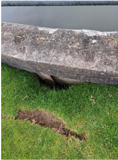
FIGURE 5 EXEMPLE DE TROU À PROXIMITÉ DU MURET (CFSJ, 2025)
