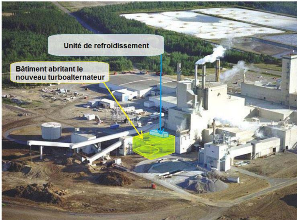
FIGURE 3 : VUE ARRIÈRE DE L'USINE ET EMPLACEMENT DU FUTUR TURBOALTERNATEUR 4
