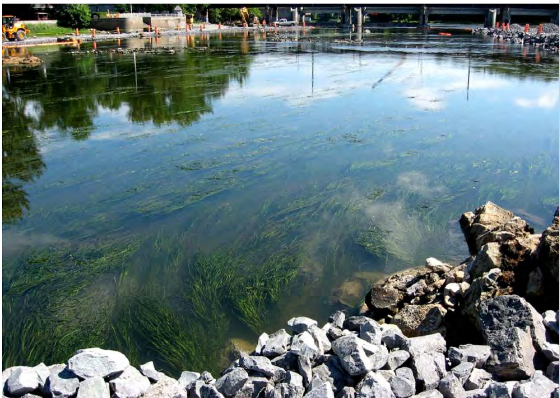
FIGURE 2 : HERBIER SUR LE SITE DES TRAVAUX D'EXCAVATION
