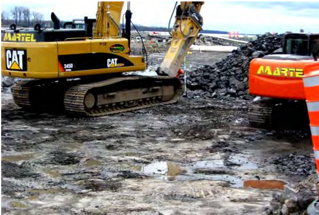
FIGURE 4 : ROC LISSE APRÈS L'EXCAVATION NE CONSTITUANT PAS UN HABITAT DE QUALITÉ POUR LE POISSON (PREMIER PLAN)
