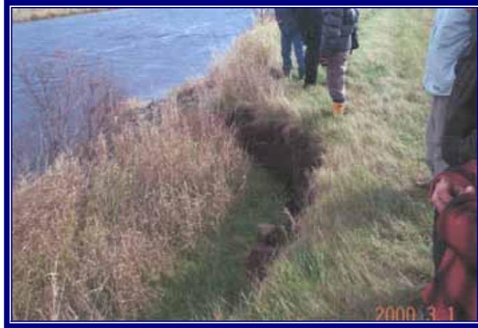
FIGURE 5: FISSURE DANS LE HAUT DU TALUS DANS LE SECTEUR NUMÉRO 6 DE LA RIVIÈRE OUELLE
