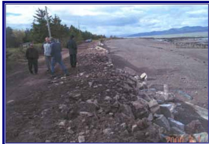
FIGURES 6 ET 7 : DÉGRADATION DE LA RIVE LE LONG DES CHEMINS DE LA POINTE ET DES GRÈVES EST EN BORDURE DU FLEUVE SAINT-LAURENT
