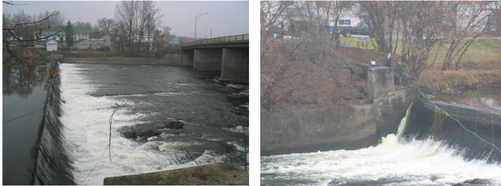
Application du TFM au barrage de Swanton, au Vermont (photos : VTFWD, 2008)
