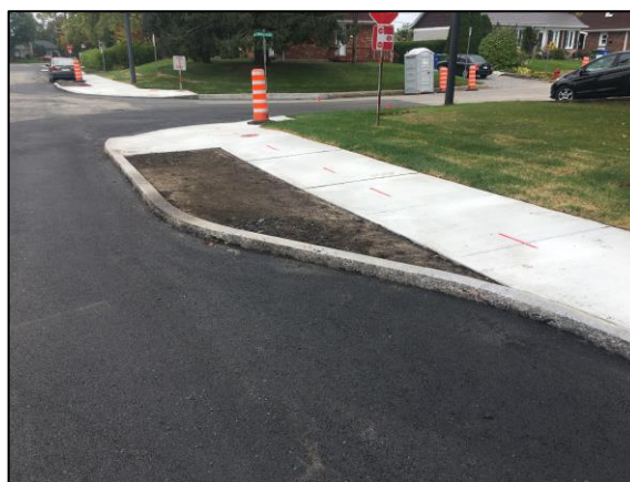
Figure 19-40. Exemple d'un réaménagement d'une rue où des avancées de trottoir ont été ajoutées avec bordure pleine n'offrant aucune possibilité de gestion des eaux pluviales.
