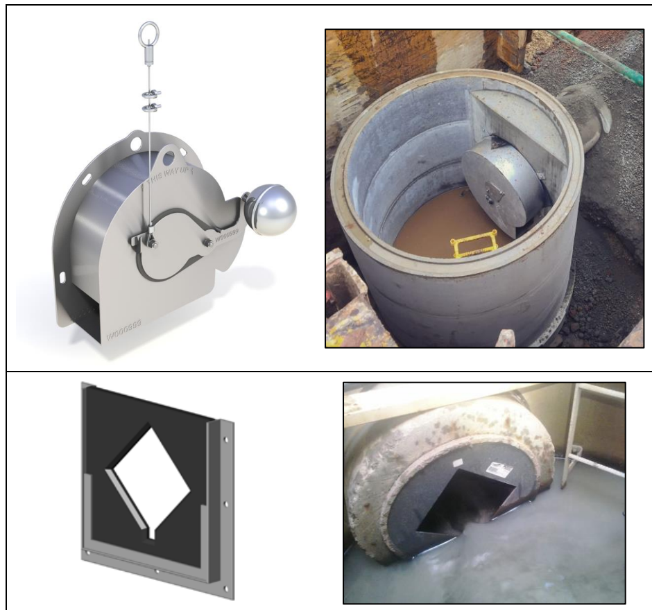
Figure 19-55. Exemples de régulateurs de débit : régulateur à vortex (en haut) et plaque-orifice (en bas)
