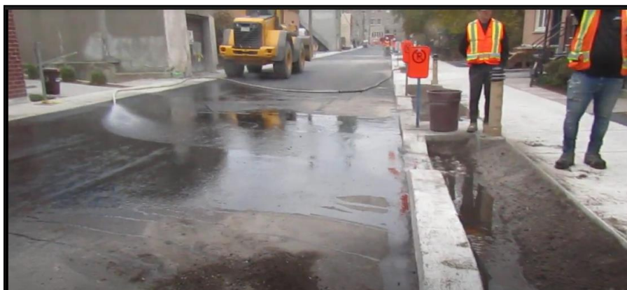
Figure 19-52. Essai de mise en service d'une infrastructure végétalisée avant l'acceptation des travaux pour démontrer que les eaux s'écoulent bien vers celle-ci. Cet essai est exigé par la Ville de Montréal.
