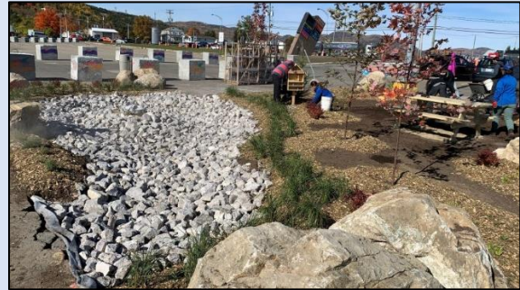
Figure 19-8 Espace déminéralisé dans un stationnement d'un centre commercial à Baie-Saint-Paul.
