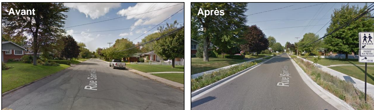
Figure 19-14. Pour régler un problème de refoulement d'égout et de débordement d'eaux usées, la Ville de Granby a modifié la rue Saint-André Est sur une longueur de 1 130 m. La largeur de la rue a été réduite de 12 m à 7 m (des espaces de stationnement ont été conservés à certains endroits où la largeur de la rue atteint 9,7 m) et des îlots de biorétention ont été installés de part et d'autre de la chaussée dans l'espace récupéré. Cette solution a été réalisée en 2013 au coût de 2,35 millions de dollars, une économie de 1,35 million comparativement à la solution initialement envisagée qui était axée sur le stockage des eaux dans des conduites surdimensionnées au coût estimé de 3,7 millions de dollars. Cette solution a aussi permis de réduire la vitesse de circulation à proximité d'une école et d'accroître le verdissement de la ville.
