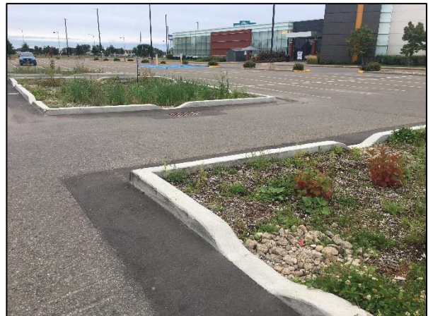
Figure 19-3 Aménagement d'îlots de biorétention dans un stationnement commercial financé par le Programme de verdissement et de déminéralisation de terrains non municipaux de la Ville de Québec.
