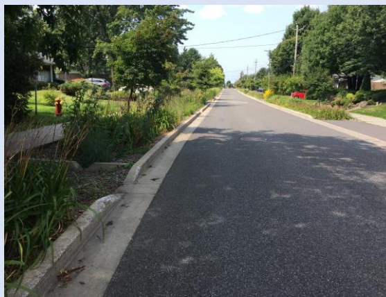
Figure 21-2. Îlots de biorétention aménagés à Granby pour solutionner une problématique en remplacement de la solution initialement envisagée de surdimensionner les conduites
