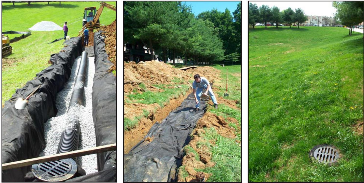
Figure 19-54. Installation d'une conduite perforée
