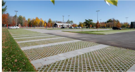
Source : Québec Vert (2022) Pavés alvéolés engazonnés au stationnement du parc du Bois-Brûlé, à Saint-Charles-Borromée
