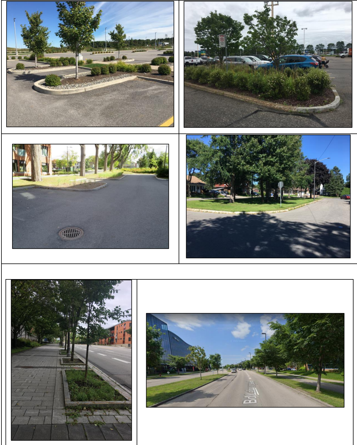
Figure 19-41. Exemple d'îlots verts dans des lieux publics ne permettant pas de capter et d'infiltrer les eaux pluviales en raison de l'installation de bordures continue. La considération des eaux pluviales au moment de la conception aurait pu faire de ces îlots des ouvrages d'infiltration à faibles coûts supplémentaires.
