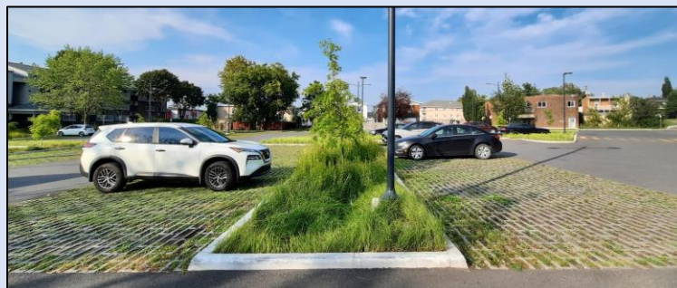
Figure 19-17. Exemple de réhabilitation du stationnement Pierre-Laporte, à Victoriaville, dans un souci de réduire les eaux de ruissellement avec l'ajout d'îlots de biorétention et de cases de stationnement en pavés alvéolés engazonnés. Ce réaménagement a permis une réduction de 75 % des volumes des eaux ruisselées et captées par le système d'égout (Victoriaville, 2022).
