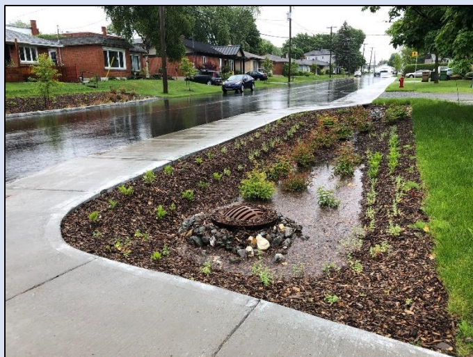
Figure 19-10 Îlot de biorétention sur la rue Madeleine à Victoriaville captant les eaux pluviales de la rue à la place des puisards.
