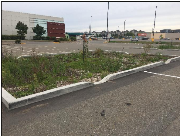
Figure 19-3 Aménagement d'îlots de biorétention dans un stationnement commercial financé par le Programme de verdissement et de déminéralisation de terrains non municipaux de la Ville de Québec.
