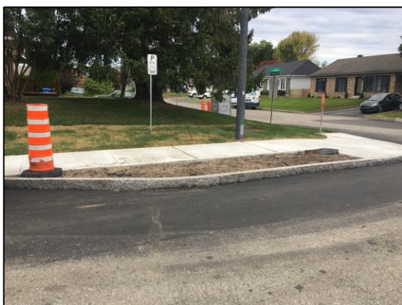
Figure 19-40. Exemple d'un réaménagement d'une rue où des avancées de trottoir ont été ajoutées avec bordure pleine n'offrant aucune possibilité de gestion des eaux pluviales.
