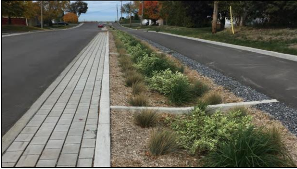
Source : Université Laval/Rose Senneville Pavés perméables autobloquants en bordure de la rue Sainte-Claire (Rivière-du-Loup)
