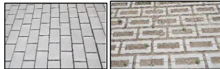
Source : Ville de Boucherville Stationnement de Montarville (Boucherville) utilisant des pavés perméables autobloquants et des pavés alvéolés
