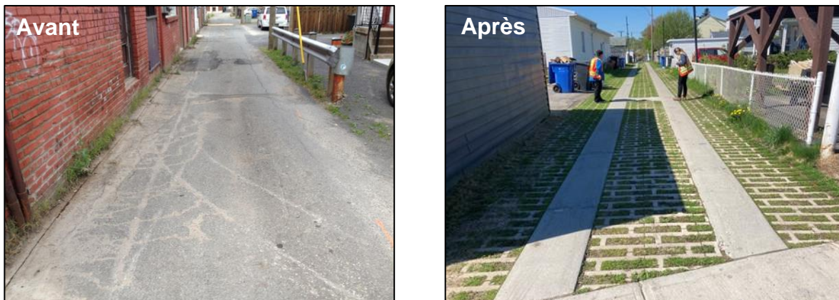
Figure 19-24. Utilisation des pavés alvéolés à Trois-Rivières pour créer des ruelles vertes
