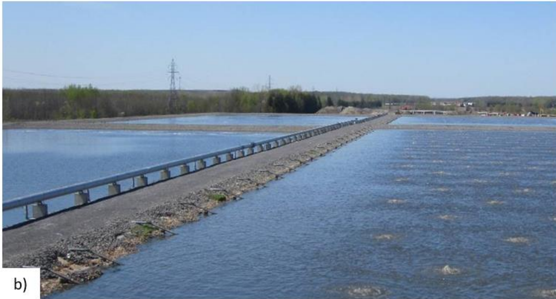
Figure 9.2.5-1 – Exemples a) d'un garde-corps et b) d'une rampe de ventilation servant de barrière physique aux étangs aérés de Le Gardeur (Ville de Repentigny)
