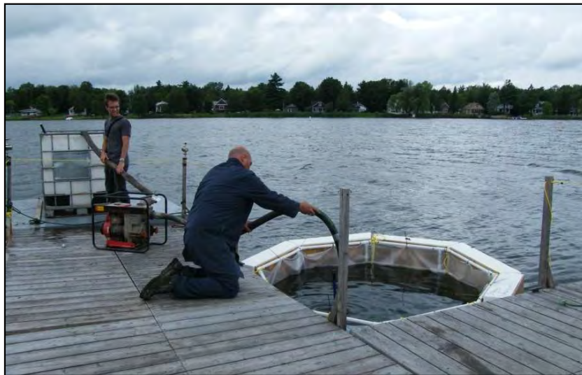
Figure III-11 Dragage hydraulique à l'aide d'une motopompe et de son tuyau d'aspiration
