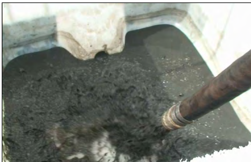
Figure III-12 Sédiments refoulés dans une cuve par la motopompe
