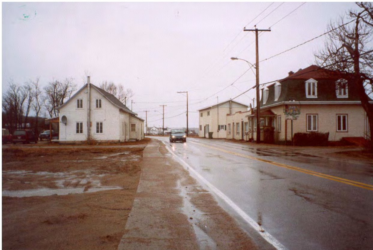
Figure 1 : Route 138 à Portneuf-sur-Mer : étroitesse de la route et faible marge de recul des bâtiments
