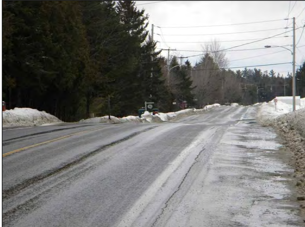
05-Barrage_Commentaires.jpg 17-02-2012 Chemin du Barrage, nombreux accès dans le secteur bâti, en bordure du lac St-François
