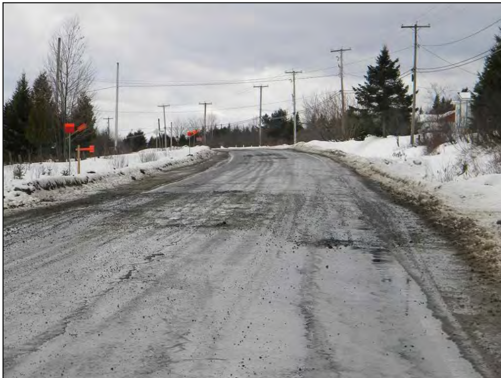
02-Barrage_Commentaires.jpg 17-02-2012 Chemin du Barrage/Rang 6, structure de la route déficiente et chaussée très dégradée dans le secteur entre Disraëli et le lac
