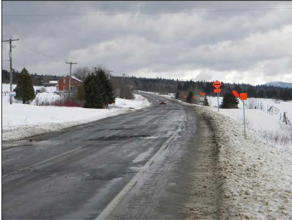
01-Barrage_Commentaires.jpg 20-02-2012 Chemin du Barrage/Rang 6, structure de la route déficiente et chaussée très dégradée dans le secteur entre Disraëli et le lac
