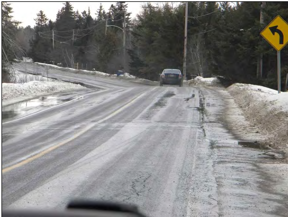
04-Barrage_Commentaires.jpg 17-02-2012 Chemin du Barrage, courbe serrée et dénivellé dans le secteur bâti, en bordure du lac St-François
