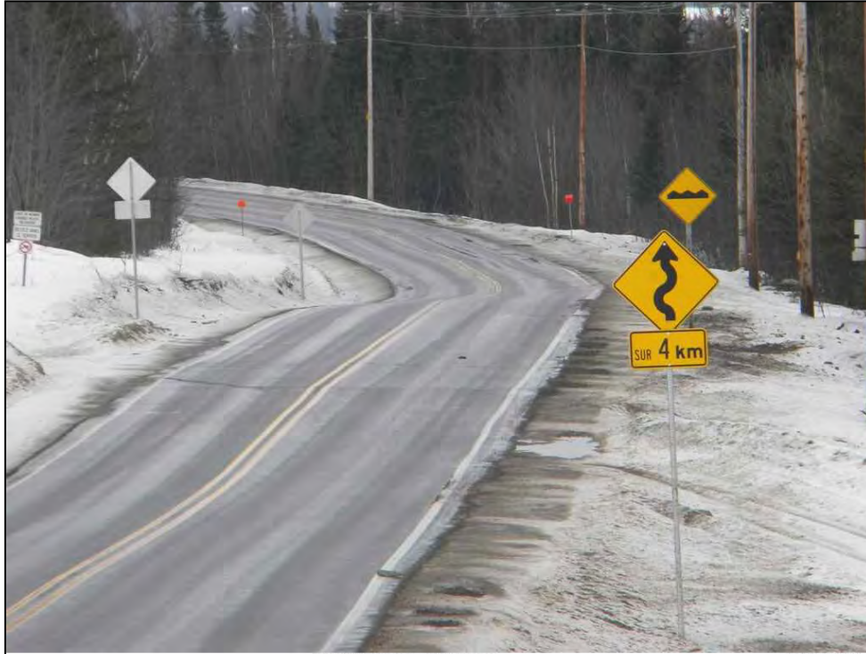
09-Vimy_Commentaires.jpg Chemin de Vimy, secteur au sud du noyau urbain; vitesse affichée de 80 Km/hre Structure de chaussée déficiente pour une route pavée en 2011
