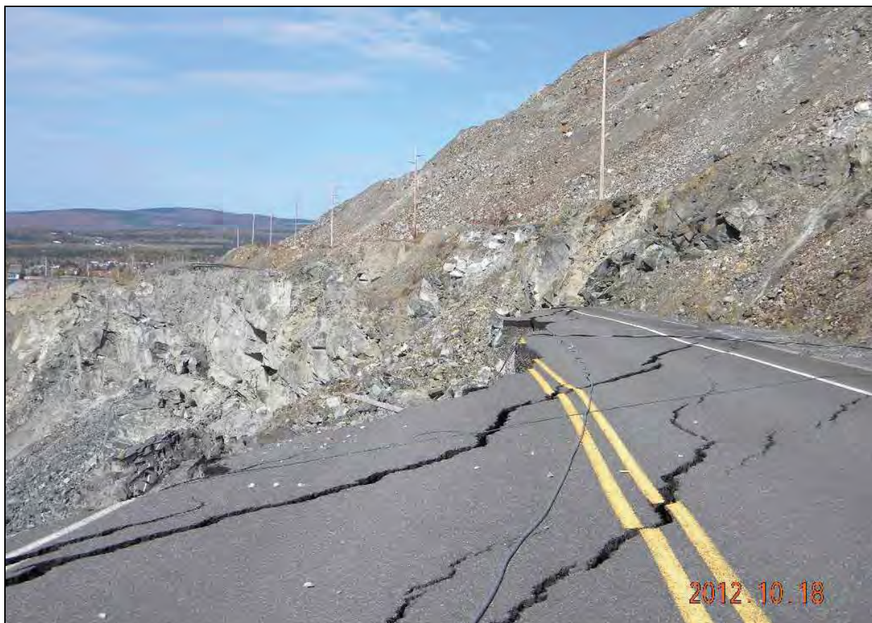
FIGURE 1 ROUTE 112 EMPORTÉE – VUE VERS LE NORD
