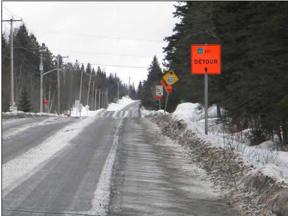
07-Barrage_Commentaires.jpg Chemin du Barrage, limite de vitesse à 80 Km/hre au nord du lac St-François Visibilité réduite, tructure de la route déficiente et chaussée dégradée
