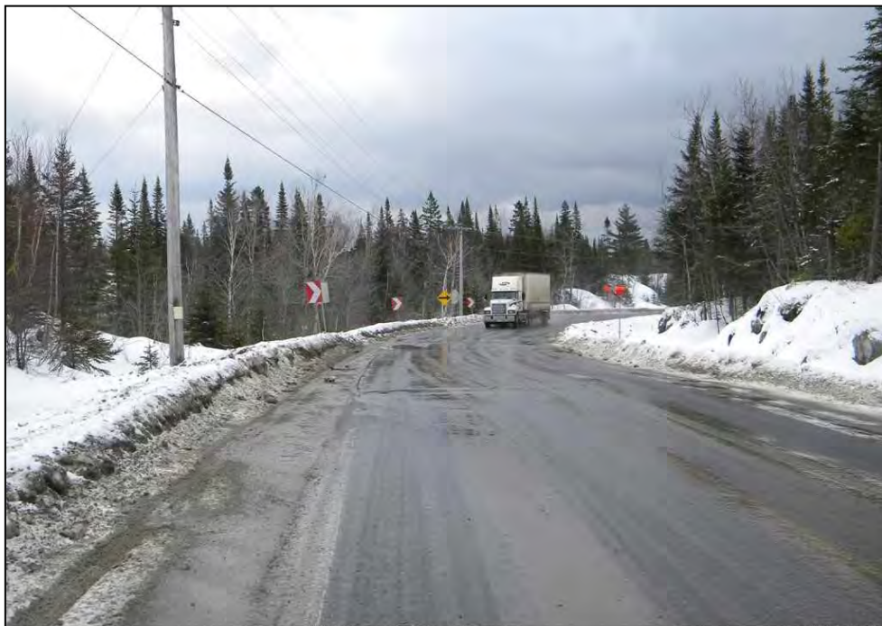
08-Barrage_Commentaires.jpg Chemin du Barrage, limite de vitesse à 80 Km/hre au nord du lac St-François Visibilité réduite, tructure de la route déficiente et chaussée dégradée
