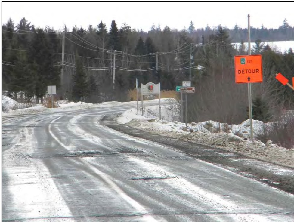
03-Barrage_Commentaires.jpg 17-02-2012 Chemin du Barrage/Rang 6, structure de la route déficiente et chaussée très dégradée, limite municipale de St-Joseph-de-Coleraine
