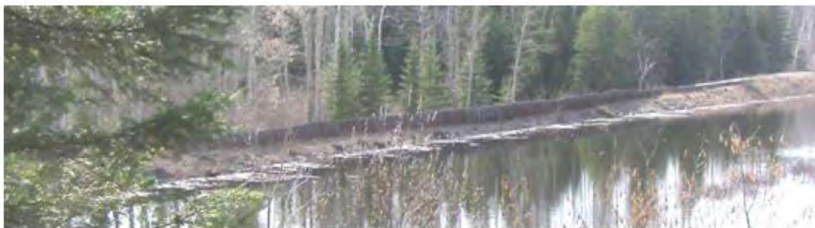
Photo 3 - Digue 3, le 21 Avril, 2006
