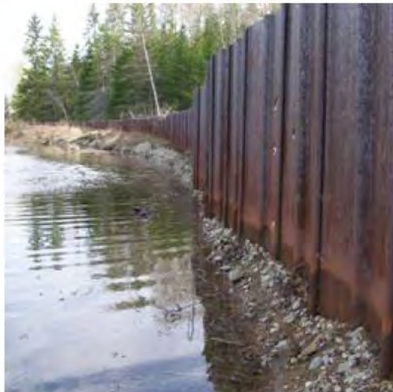
Photo 2 - Digue 4, le 21 Avril, 2006
