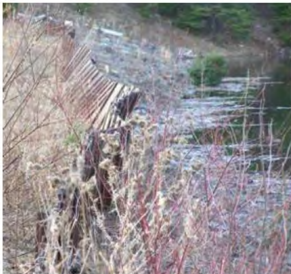
Photo 1 - Digue 1, le 21 Avril, 2006
