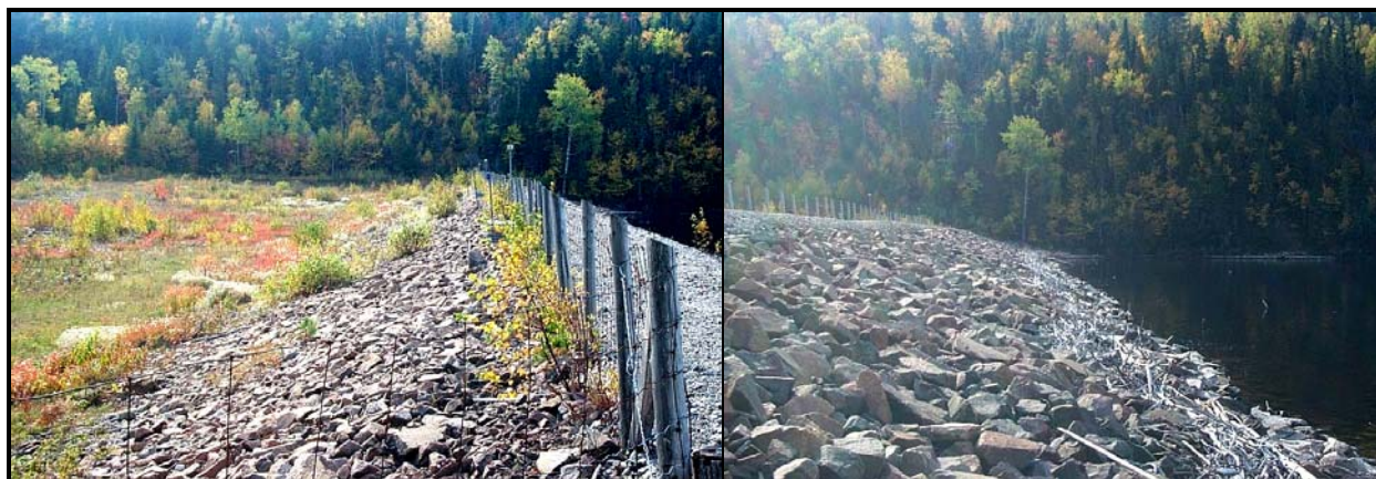
FIGURE 8 : VÉGÉTATION RECOUVRANT LA DIGUE MONCOUCHE ET ENROCHEMENT DU PAREMENT AMONT DE LA MÊME DIGUE
