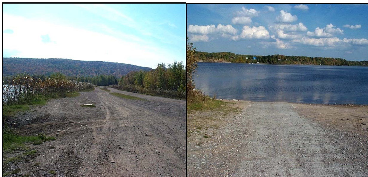
FIGURE 6 : CHEMIN QUI PERMET D'ACCÉDER À LA RIVE SUD DU LAC KÉNOGAMI EN PASSANT DIRECTEMENT SUR LA DIGUE OUIQUI (À GAUCHE) ET RAMPE DE MISE À L'EAU LOCALISÉE SUR LA RIVE SUD DU LAC (À DROITE)
