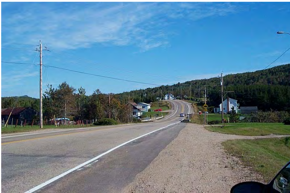
FIGURE 3 : SECTEUR DE LA TRAVERSÉE DE LA RIVIÈRE À LA LOUTRE, VUE VERS L'EST
