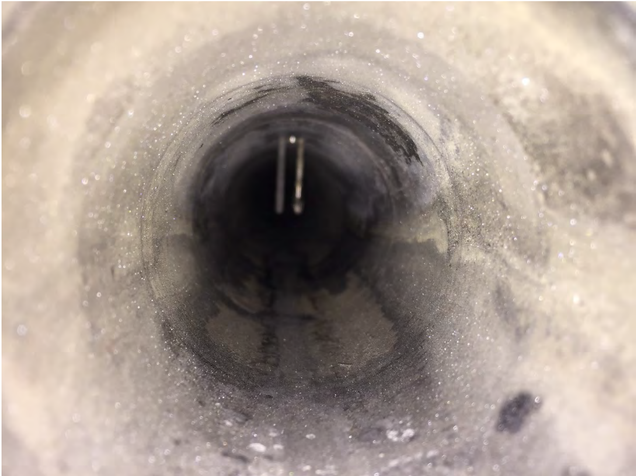
Photo du débitmètre de Mont-Laurier lors de l'inspection du 26 octobre 2017
