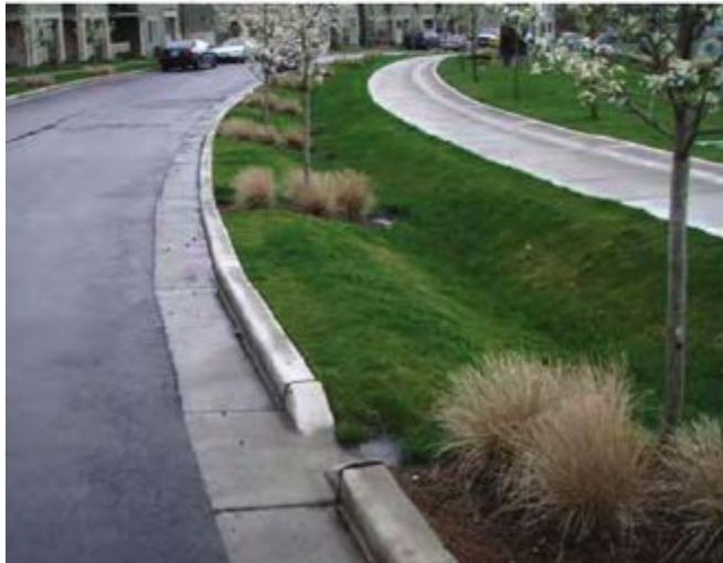
Figure 11.51 Exemples d'aménagement pour noue ou fossé sans retenue permanente.
