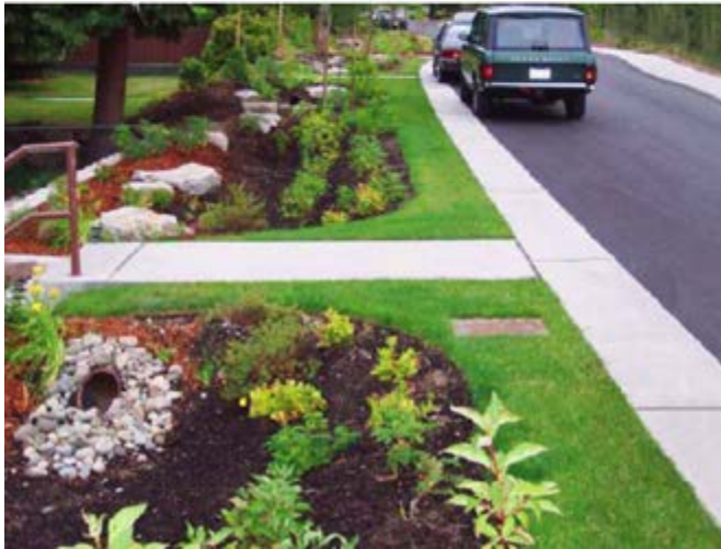
Figure 11.57 Exemples de noue pour autoroute, boulevards urbains ou rue de secteur résidentiel avec zone de biorétention.
