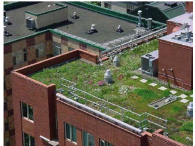
Figure 11.38 Exemple d'aménagement pour un toit vert (Ville de Portland).
