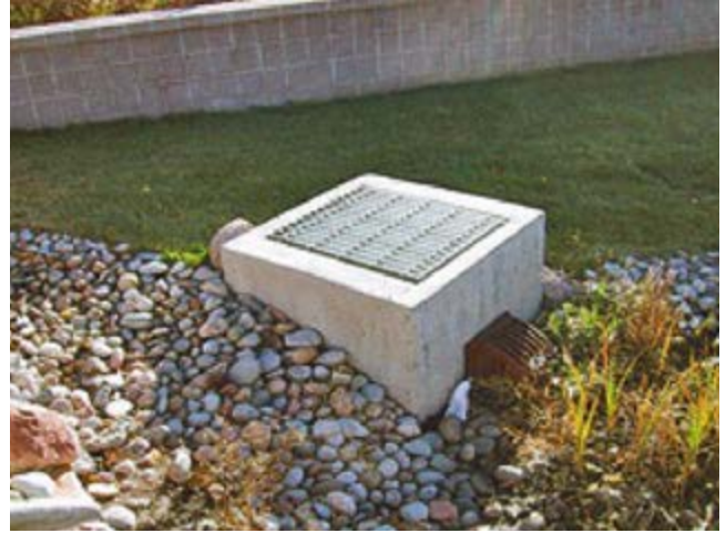
b. Ouvrage de sortie avec une grille.
