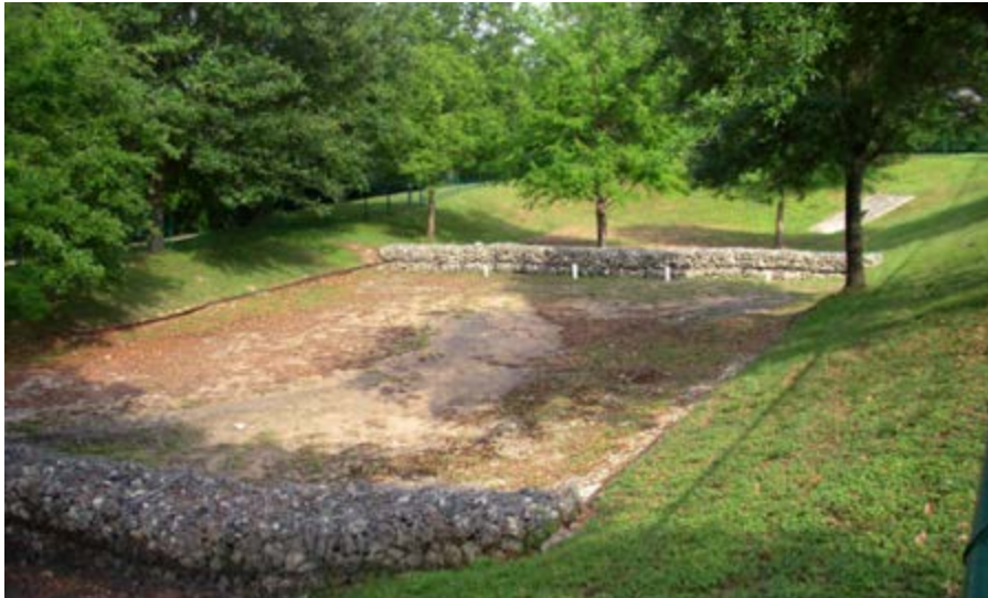
Figure 11.89 Aménagement d'un filtre à sable de surface.
