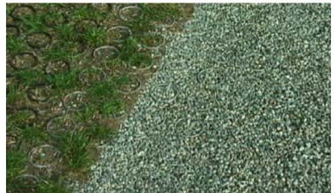
Figure 11.42 Système de pelouse renforcée (GVSD, 2005).
