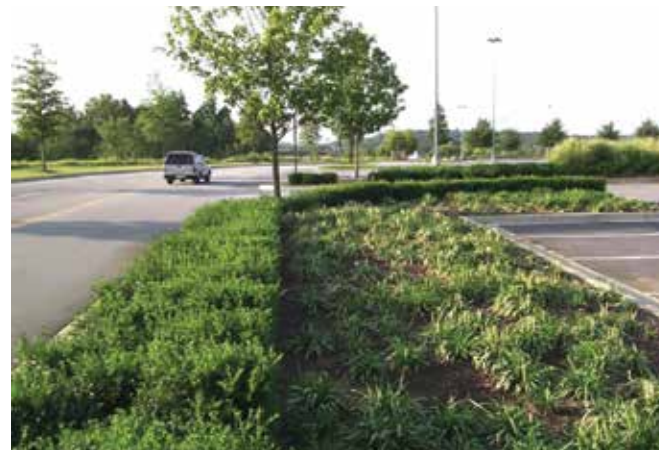
Figure 4.16 Zones de traitement pour un stationnement.
