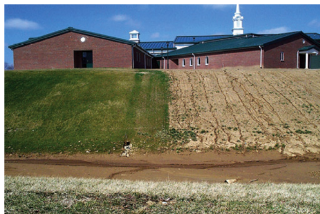
Figure 8.16 Exemple de sol remanié non protégé.
