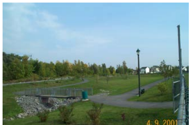
Figure 11.8 Exemple de bassin avec clôture. Le bassin inclut des aires de promenade mais l'accès y est interdit en cas de pluie (cadenas à la clôture).
