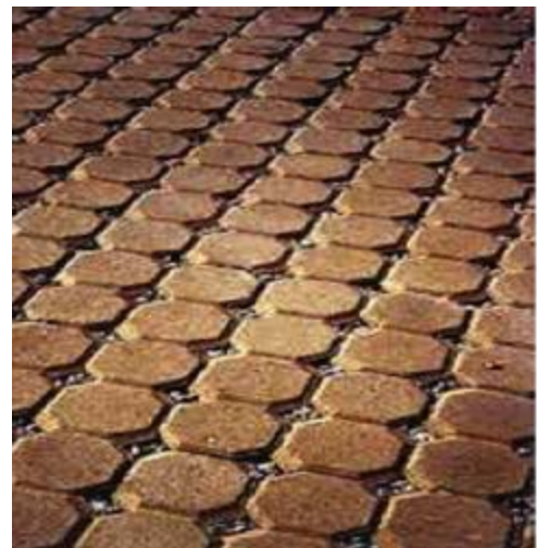
Figure 11.41 Blocs de béton poreux comme revêtement de surface.
