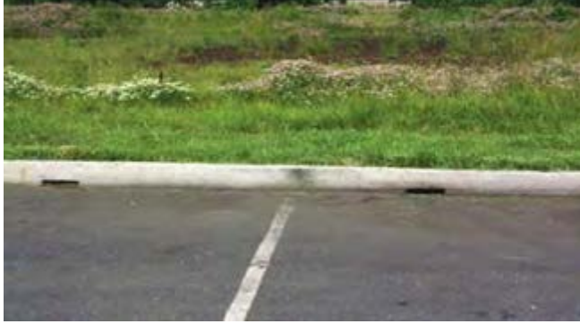
Figure 11.22 Utilisation d'une bande filtrante comme prétraitement à d'autres techniques.
