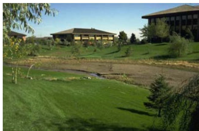
Figure 11.3 Accumulation de sédiments à l'intérieur d'un bassin sec sans prétraitement.
