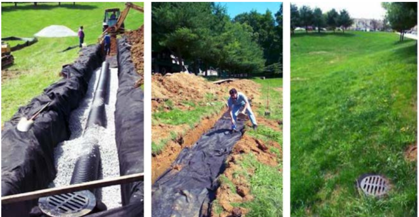
Figure 11.61 Installation d'un système avec conduites perforées.
