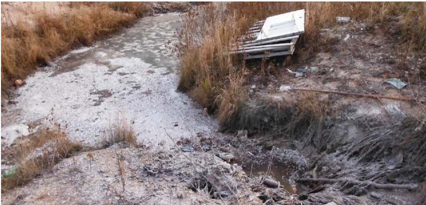
Tranchées à fosse septique
