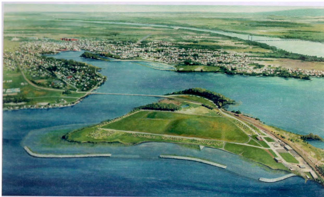
FIGURE 2 : SIMULATION VISUELLE DU PROJET DE RESTAURATION DES SÉDIMENTS DE L'ÎLE AUX CHATS (TIRÉE DE L'ÉTUDE D'IMPACT)
