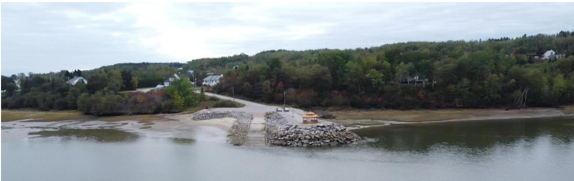
Figure 61. Rampe de mise à l'eau sur la rive ouest de la rivière Portneuf (2021)
